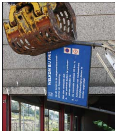
Niets blijft gespaard voor de slopershamer
